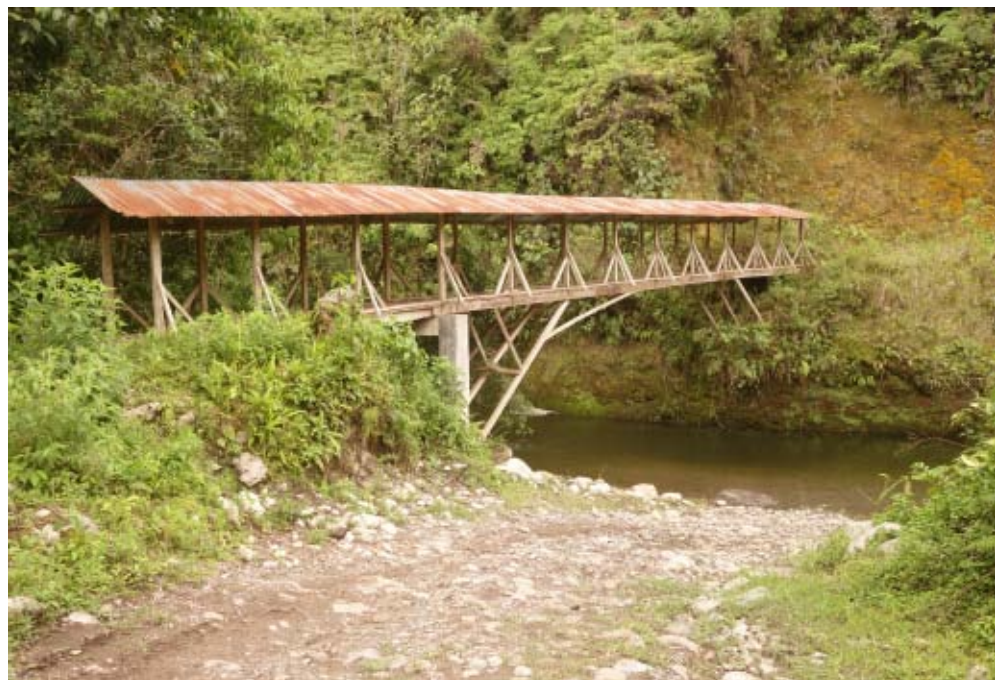
▲ Pont sur le Rio Salas – Cliché Jean-Yves Bigot
