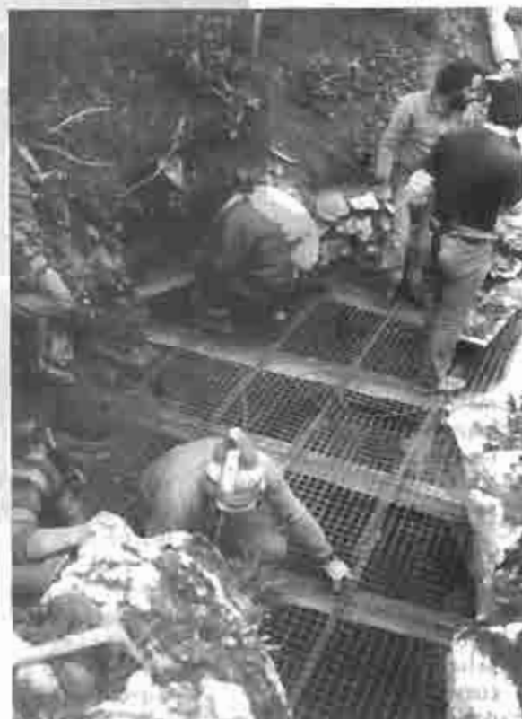
● Dimanche 17, 8 h 15. Les 5 barres IPN sont scellées. Au-dessus, on a posé 3 tubes rectangulaires et la soudure a commencé; le groupe électrogène a été monté au bord même du trou.
