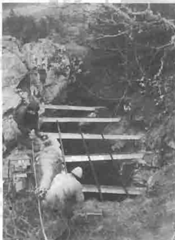
● Dimanche, 17 h: Les travaux touchent à leur fin. On active de poser et de souder les dernières grilles.
