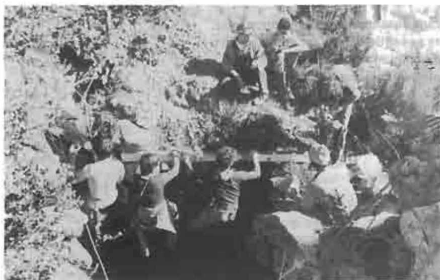
Samedi 16-02-90. Travaux de fermeture de l'aven du Prat del Vedelh. La 1 ère barre IPN est pratiquement en place.
